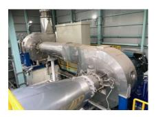
**蒸気ドレン回収装置の導入** | 廃棄していた蒸気ドレンを回収
